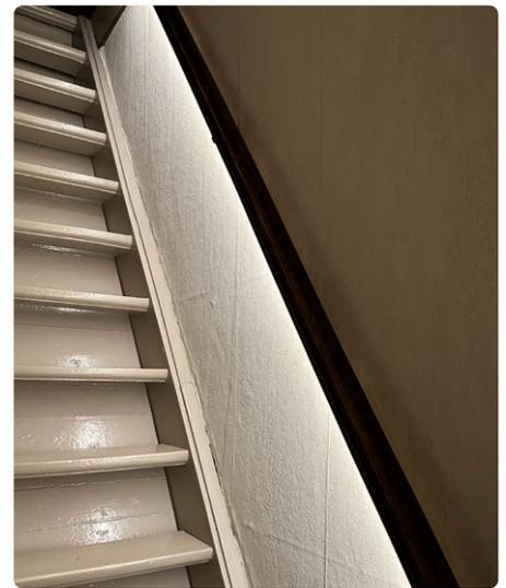
*Bild 1. Der Autor beleuchtet mit der beschriebenen Schaltung sein sehr steiles Treppenhaus. Auf keinen Fall darf das Licht ausgehen, wenn sich jemand auf der Treppe befindet. Die LED-Leiste ist unter dem Treppengeländer montiert und beleuchtet die Stufen. Der Sensor befindet sich am oberen Ende der Treppe, so dass sich alle Stufen im Erfassungsbereich des Radars befinden.*
