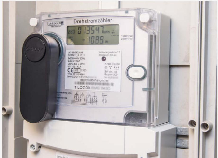
Tibber Pulse haftet magnetisch am Zähler.
