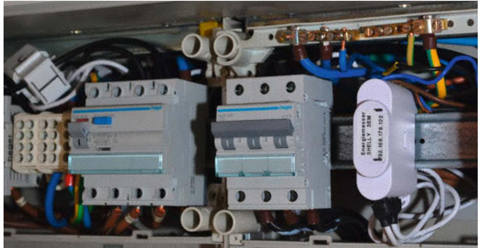
Anschluss im Verteilerkasten: rechts der Smartmeter-Baustein Shelly 3EM, links oben am herausgezogenen Kabel einer der drei Stromsensoren des Smartmeters, ein Klappferrit mit Übertragerspule
